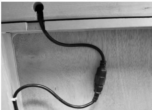
(1) Conectați prizele cablurilor de încălzire, Asigură-te că cablurile sunt bine conectate între ele
